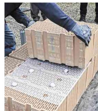
Ziegel werden punktuell verklebt und können getrennt werden. (Werk)
